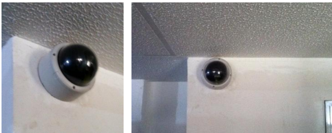
Figura. 5.12. Instalación Cámara Trendnet TV-IP252
