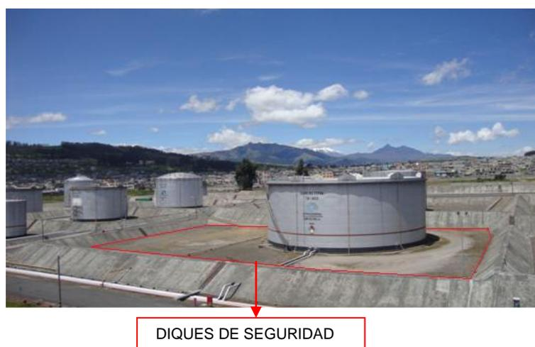
Figura 1.2. Ubicación de los tanques de almacenamiento
