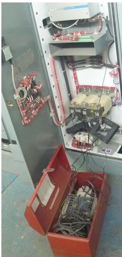
Figura 2.96. Equipo analizador de energía
