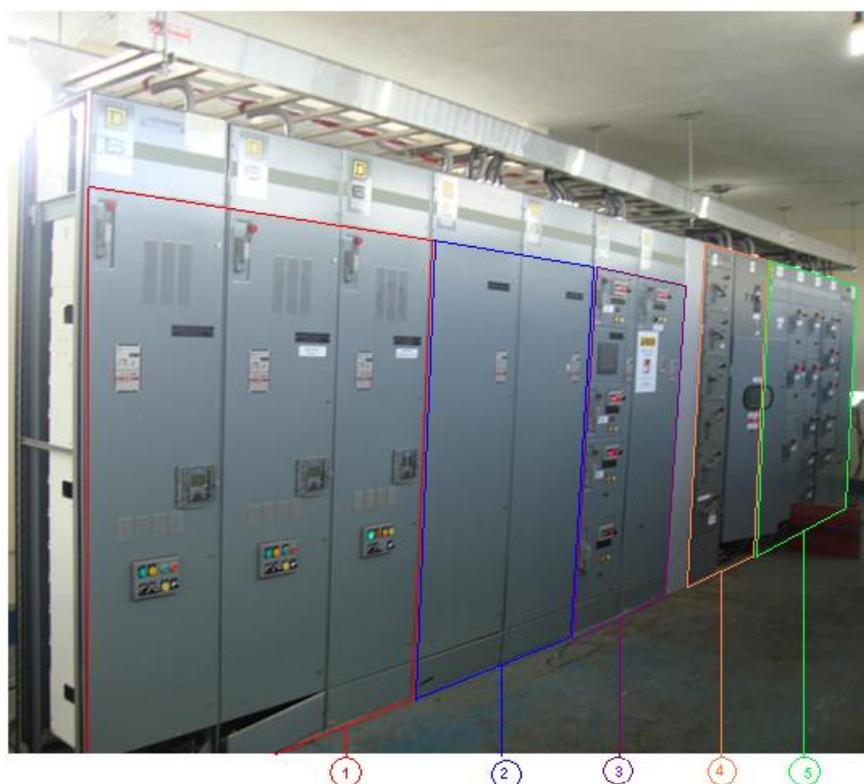
Figura 3.4. Armario de equipos del M.C.C.
