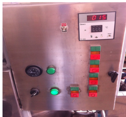
Figura 6.1 Prueba del sistema eléctrico
