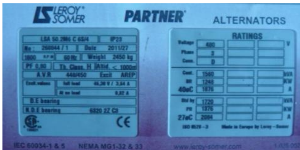
Figura. 2.5. Datos técnicos del alternador Leroy Somer
