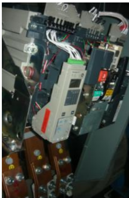
Figura. 2.33. Conexiones del interruptor de potencia
