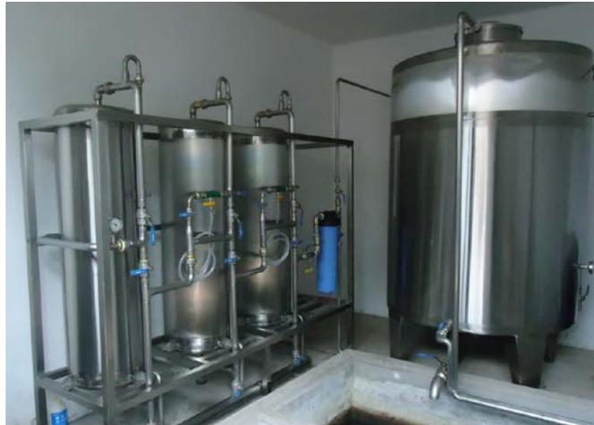
**Figura. 6.3. Desmineralizador.**
