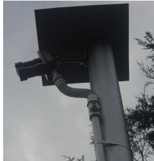
Figura 5.15.b. Instalación eléctrica del sensor de llama.
