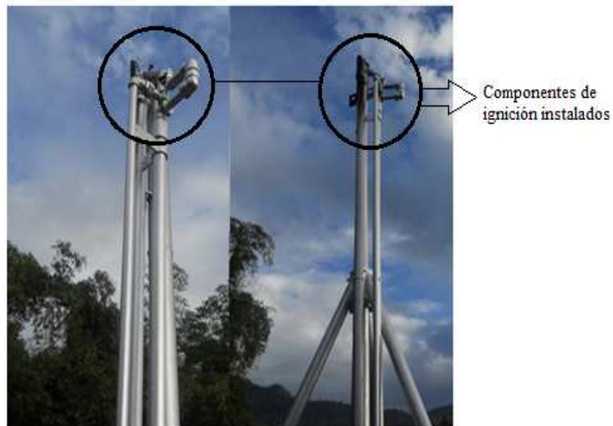
Figura 5.3. Instalación del componente de Ignición de la TEA de incineración.
