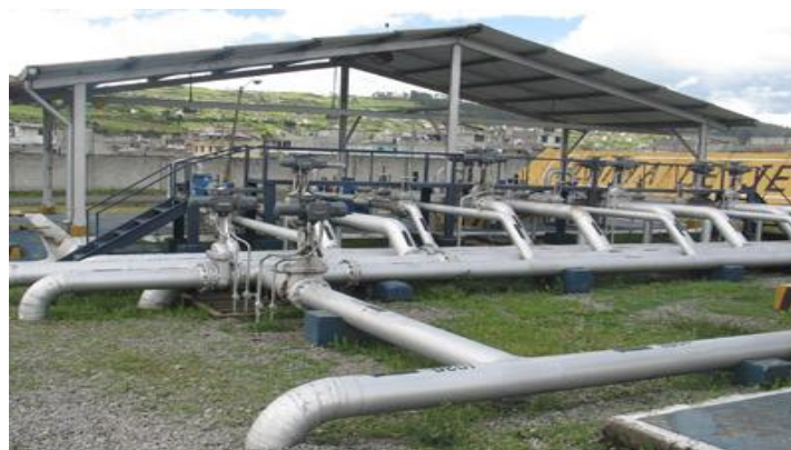
Figura 1. 12 Estación reductora
