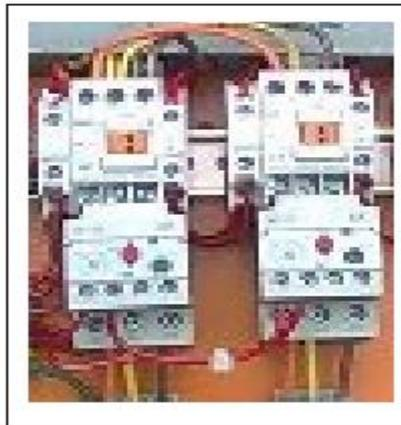
Figura 5.40: Contactores y relés térmicos.
