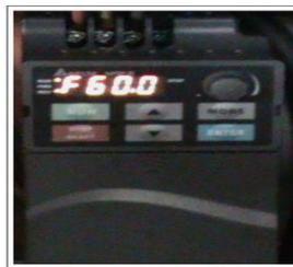
Figura 6.27: Variador de frecuencia a 3600 rpm o 60 Hz.
