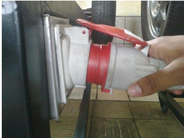
Figura. A3. Conexión del enchufe del sistema de control al motor
