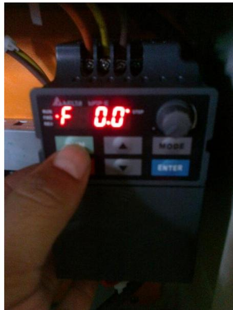
Figura A8. Accionamiento del variador de frecuencia.
