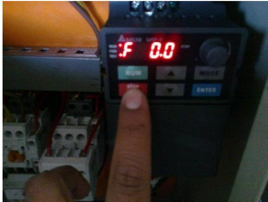
Figura A18. Variador de frecuencia en STOP.
