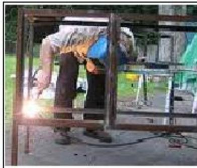
Figura 5.8: Soldado de ejes verticales de la estructura.
