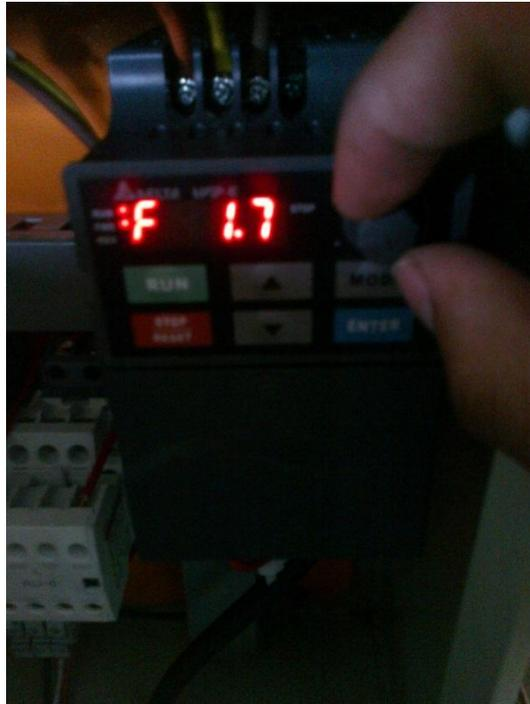
Figura A10. Accionamiento del variador de frecuencia mediante el potenciómetro.
