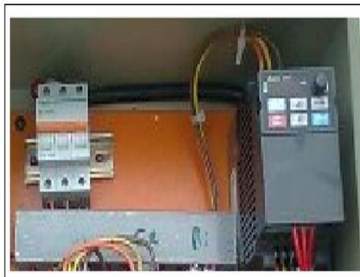
Figura 5.42: Conexión del variador de frecuencia.
