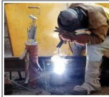
Figura 5.6: Soldando cuadro superior e inferior de la estructura.
