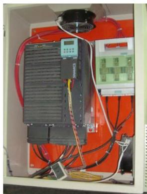
**Figura B.14** Variador de frecuencia que controla la velocidad del motor del plegado.
