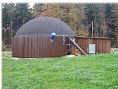
Figura 3.38 Digestor con tanque de almacenamiento tradicional y cúpula de polietileno
