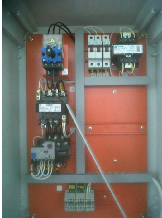
Figura 4.4 Elementos de fuerza y control de un tablero eléctrico instalado. 70
