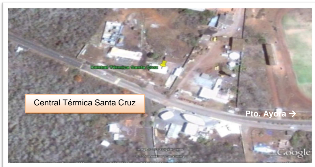
Gráfico 17 Instalaciones ELECGALAPAGOS S.A. Agencia Santa Cruz Central Térmica Elaborado por los autores con la Herramienta Google Earth
