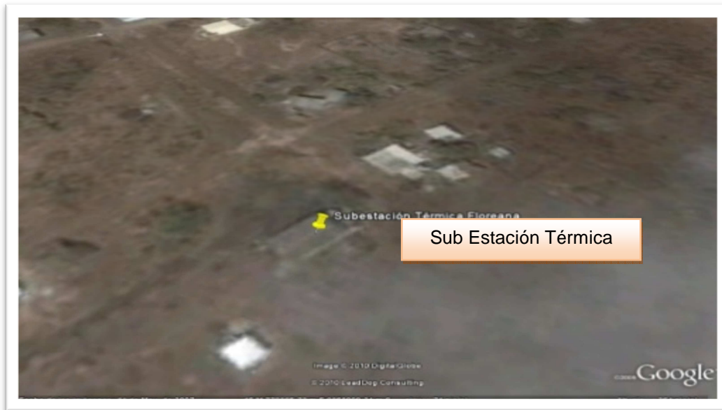
Gráfico 20 Instalaciones ELEGALAPAGOS Subestación Floreana Central Térmica con Biocombustible Elaborado por los autores con la Herramienta Google Earth
