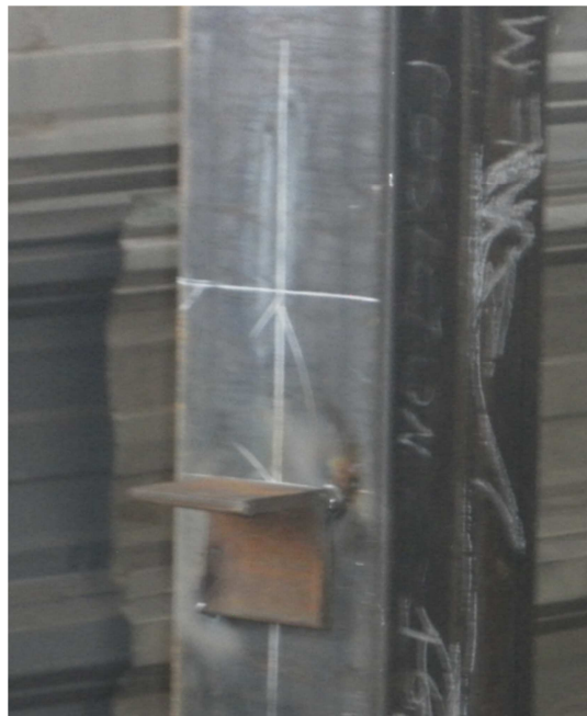
Figura 1.4 Marcas y apoyo provisional para el montaje de la viga
