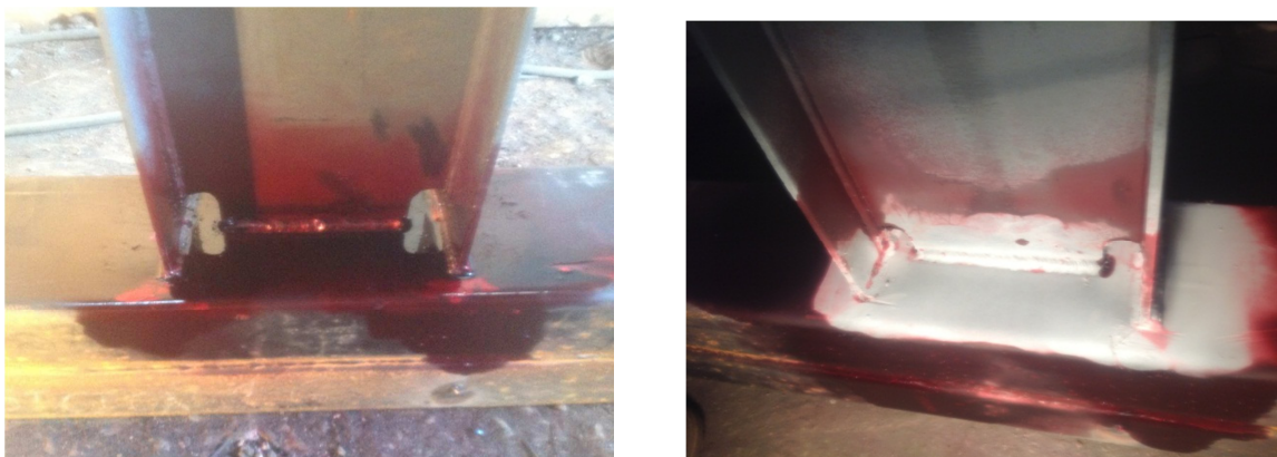
Figura 6.743 Aplicación del penetrante (iz), aplicación del revelador (der) filete 1
