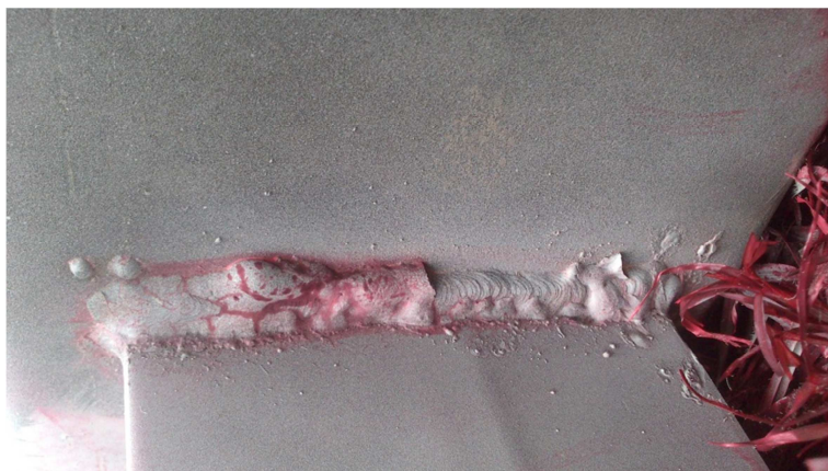
Figura 6.8 Fisuras detectadas en el ensayo de tintas penetrantes probeta VCP 01 Zona I2
