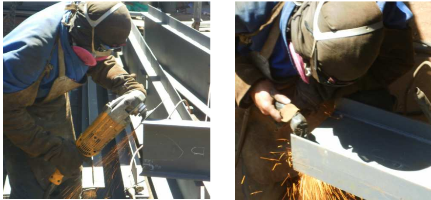
Figura 1.5 Preparación de la viga antes del montaje
