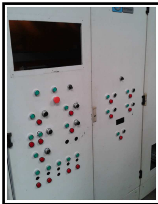
Figura 5. 9: Colocación de los elementos en las puertas (Fuente Propia, 2012).
