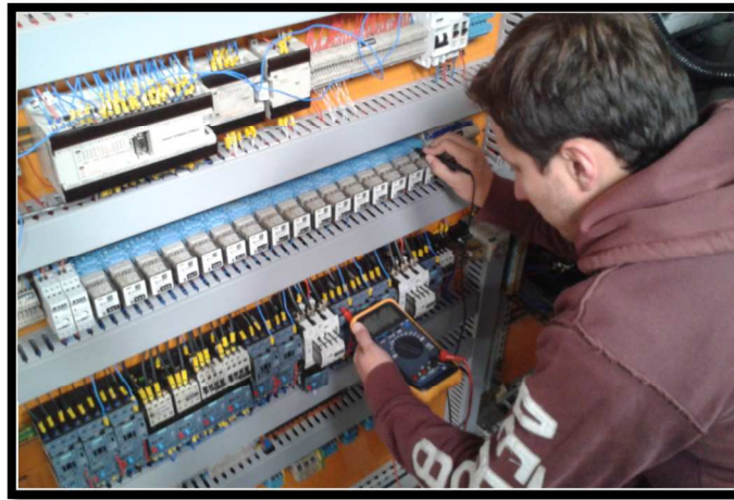
Figura 5. 20: Seguimiento de las líneas de conexión con ayuda del multímetro (Fuente Propia, 2012).
