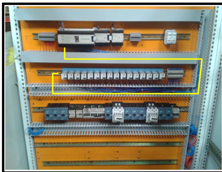
Figura 5. 16: Conexión PLC – Relés.
