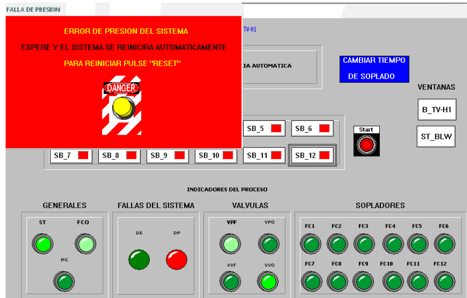
Figura 6.10 Pantalla principal con Aviso en Falla de Presión.
