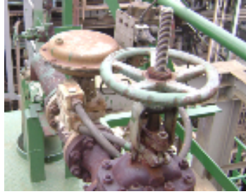
Figura 2.13 Válvula de Purga
