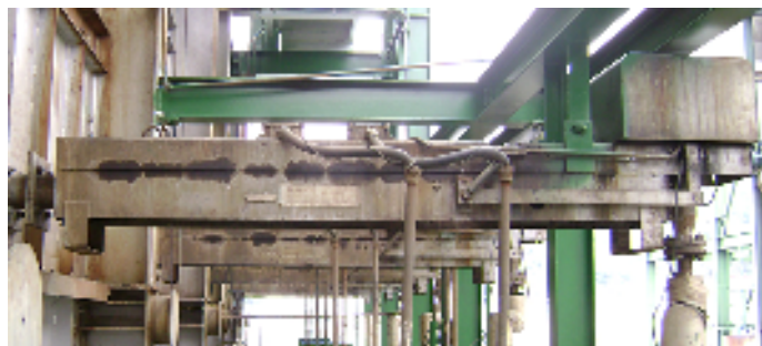
Figura 2.2 Soplador de Hollín Retractil
