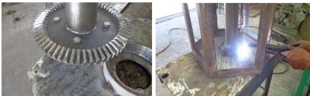
Figura 3. 4 Montaje del árbol de transmisión a la estructura inferior
