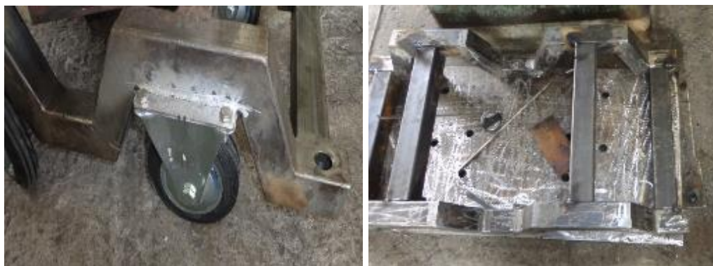
Figura 3. 6 Construcción de la estructura de soporte y desplazamiento
