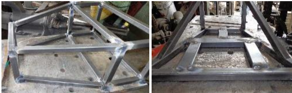
Figura 3. 1 Soldadura y acabados de la estructura Superior.
