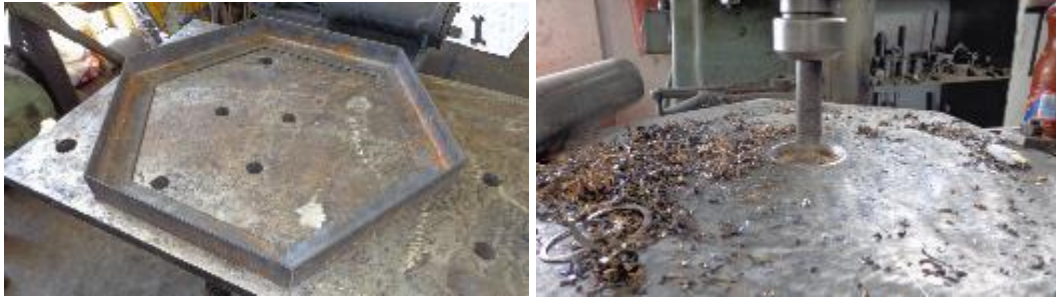
Figura 3. 3 Proceso de construcción de la estructura inferior
