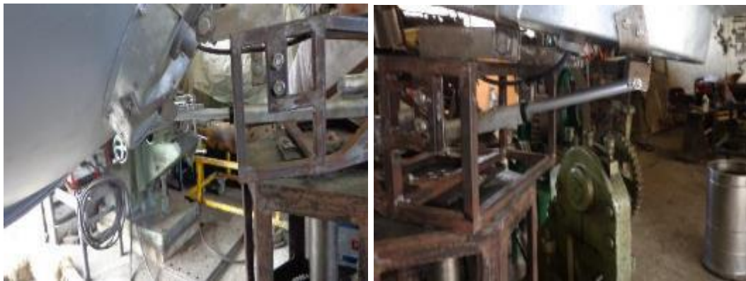
Figura 3. 2 Montaje de anclajes en la antena y la estructura superior
