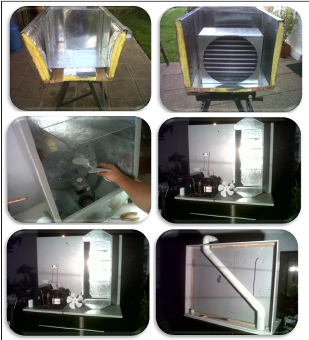
**FIGURA 4.3: CONSTRUCCIÓN DEL SECADOR**
