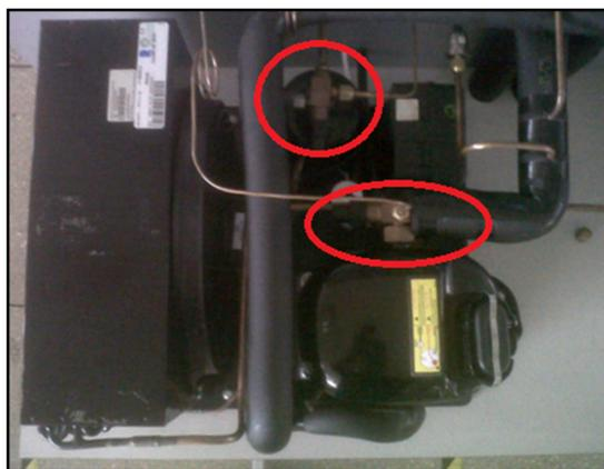
**FIGURA 3.9: VÁLVULAS DE SERVICIO EN LA UNIDAD CONDENSADORA**
