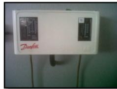
**FIGURA 3.15: PRESOSTATO DE ALTA Y DE BAJA**
