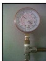
**FIGURA 3.13: MANÓMETRO DE ALTA**
