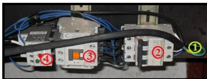
Figura 149: Instalación eléctrica para el motor trifásico.
