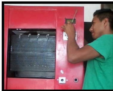
Figura 148: Instalación del LCD y placa de controles.
