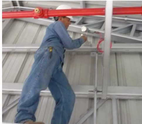
Figura. 5.16. Simulación de presencia de flama.
