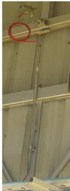
Figura. 4.4. Tubería conduit.
