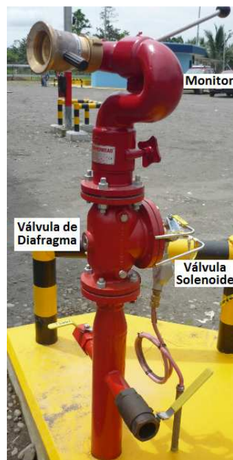
Figura. 4.18. Hidrante.
