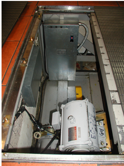
Figura 1.13 Control escaleras eléctricas
