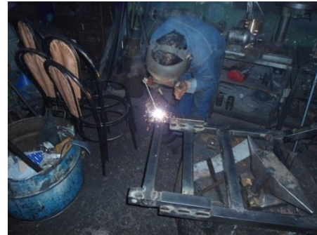
Figura 4 Ensamblaje por soldadura del bastidor
