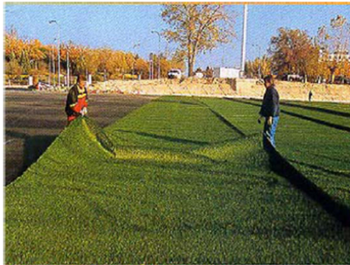
Figura 3.8. Tendido del rollo
