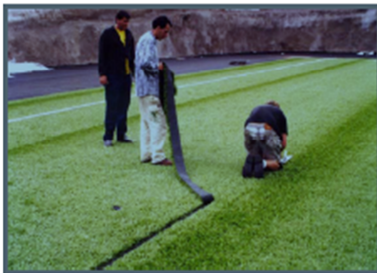
Figura 3.9. Colocación de líneas y arcos
