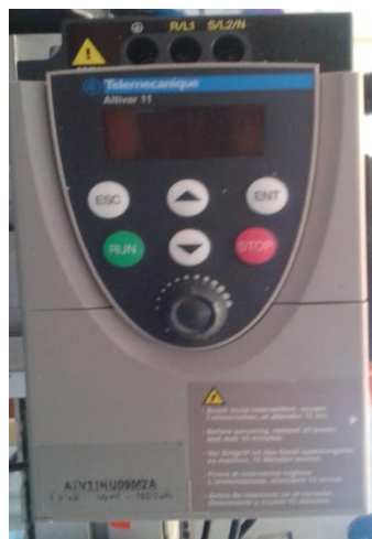
Figura 3. 11: Montaje del variador de frecuencia
