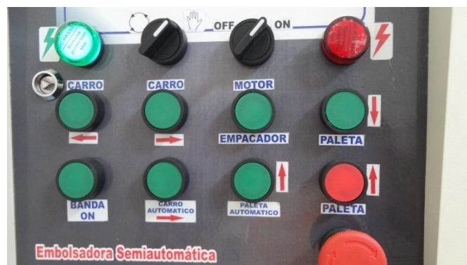
Figura 3. 10: Vista frontal de la caja de control
