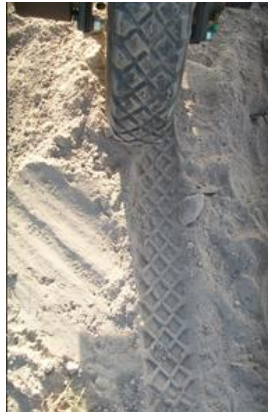
Figura. 5.7 Compactación del suelo
