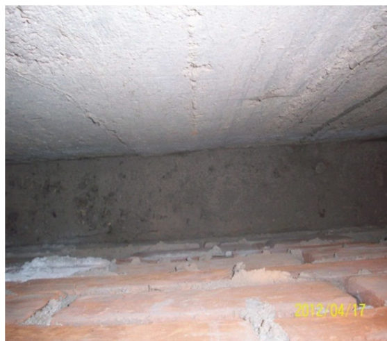
Figura. 6.45. Muro existente en el Bloque Administrativo
