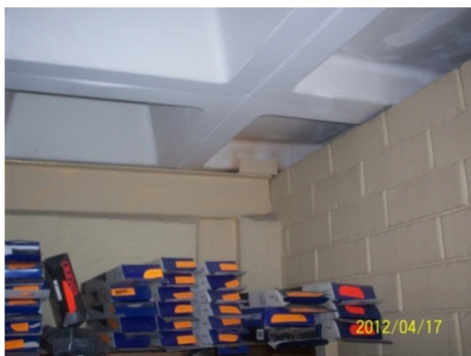
Figura. 6.37: Perfiles I añadidos bajo Losa Plana del Bloque Biblioteca
