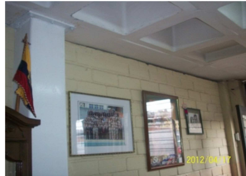
Figura. 6.36: Columna metálica Pórtico central
