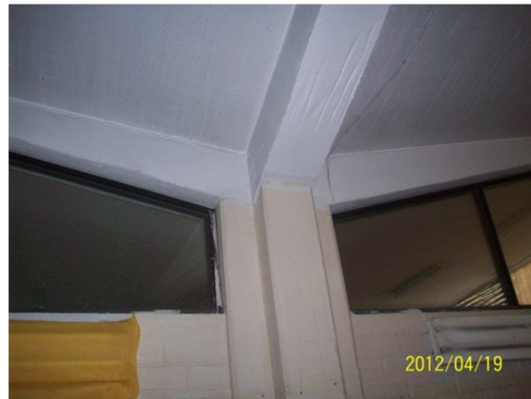
Figura. 6.5: Vigas descolgadas paraboloides individual
