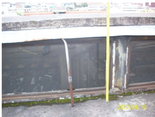
Figura 6.7: Separación bloques de paraboloides
