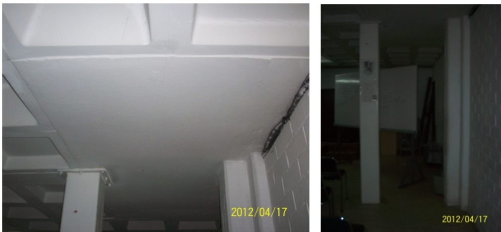
Figura. 6.32: Columnas metálicas adicionales en planta baja B. Biblioteca
