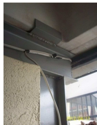
Figura. 6.37: Perfiles I añadidos bajo Losa Plana del Bloque Biblioteca
