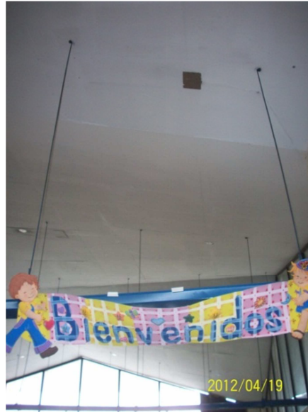
Figura. 6.23: Tensores en cubierta de paraboloides dl Bloque Talleres
