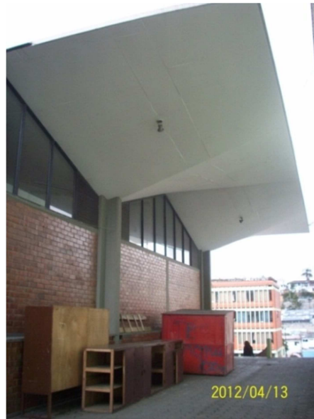
Figura. 6.18: Paraboloides del Bloque Talleres
