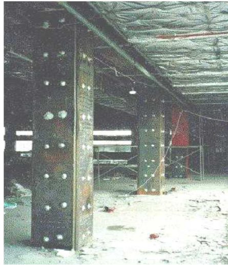
Figura 7.1. Reforzamiento estructural
