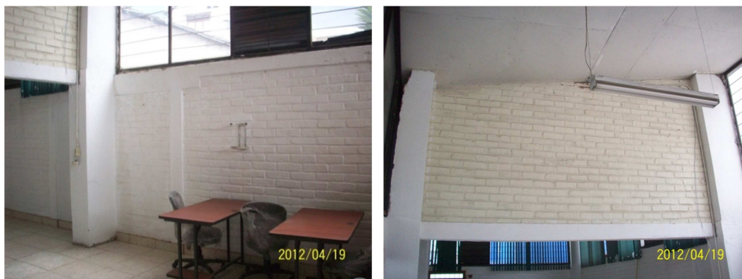
Figura. 6.25: Pórticos extras en paraboloides del bloque Talleres
