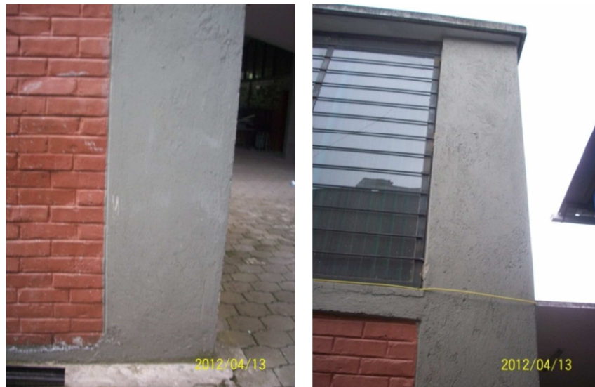
Figura. 6.22: Columna nueva en borde del paraboloïde del bloque talleres
