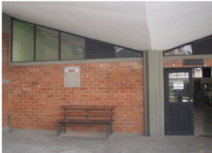
Figura 3.8: Vista in situ de columna cruz y cubierta parabólica
