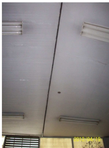
Figura. 6.4: Junta del Paraboloide individual
