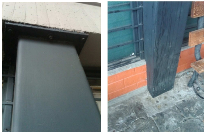
Figura. 6.38: Columnas metálicas al exterior del bloque Biblioteca.
