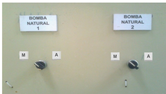
Figura 3.8 Selector de posición para el tipo de funcionamiento de los variadores
