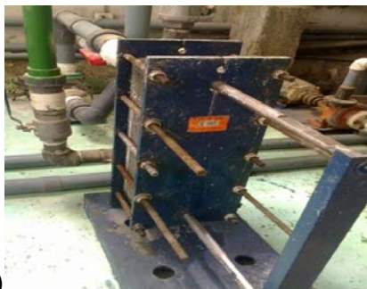
Figura 2.9 Intercambiador de calor Natural #1
