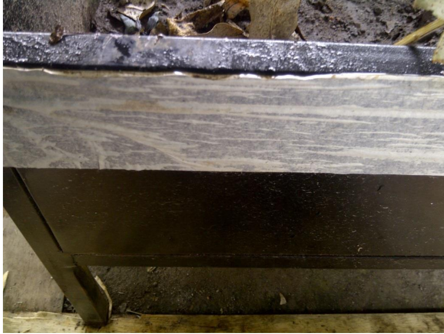
Figura 6.09. Papel Adhesivo colocado Sobre la Superficie Metálica.
