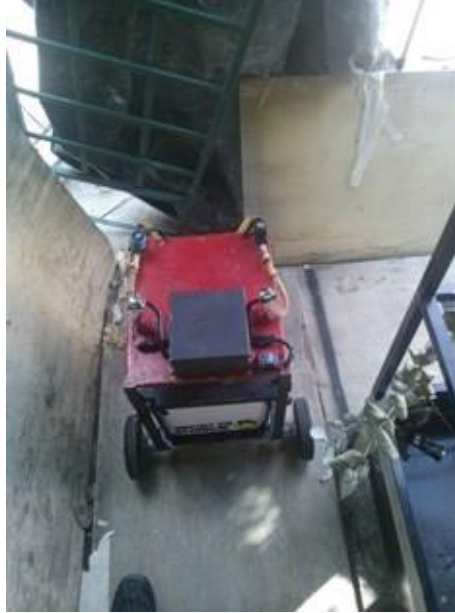
Figura 6.37. Ingreso a Cama 3.
