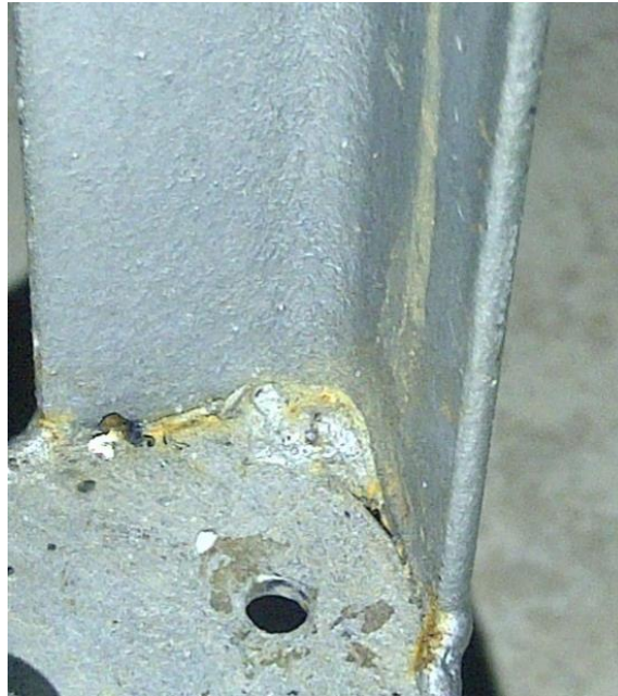
Figura 5.02. Soldadura Angulo Base.
