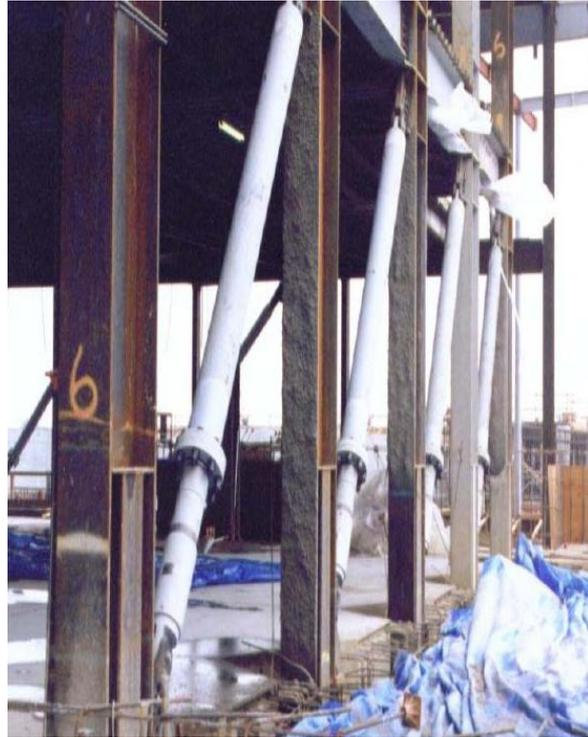
Figura 2.21 Amortiguador de fluido viscoso \*
