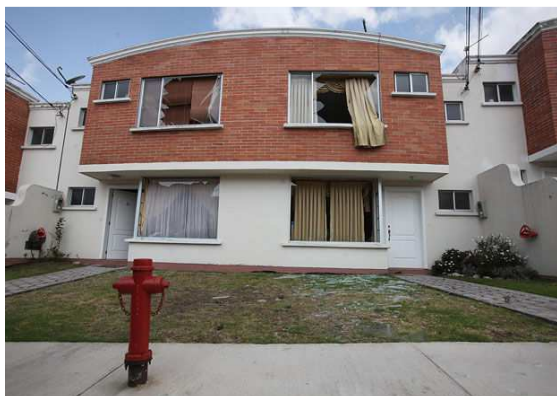
Figura 1. Fotografía de los daños materiales causados en una de las urbanizaciones adyacentes al cuartel del GIR. Fuente: ©Diario El Comercio.
