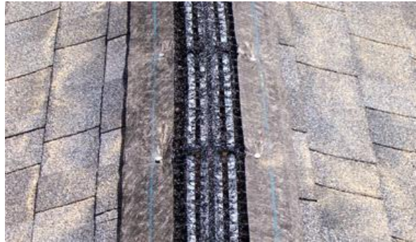
Figura 2.16 Sistema Green Ward ridge vent
