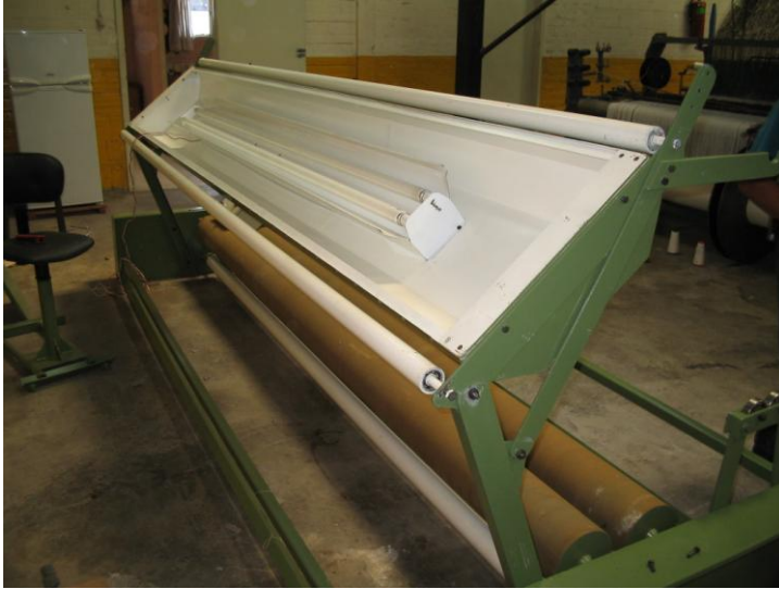
Fig. 4.6 Instalación del sistema de Iluminación
