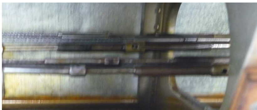
Figura 3.8: Turnbuckles del compartimiento de la cabina
