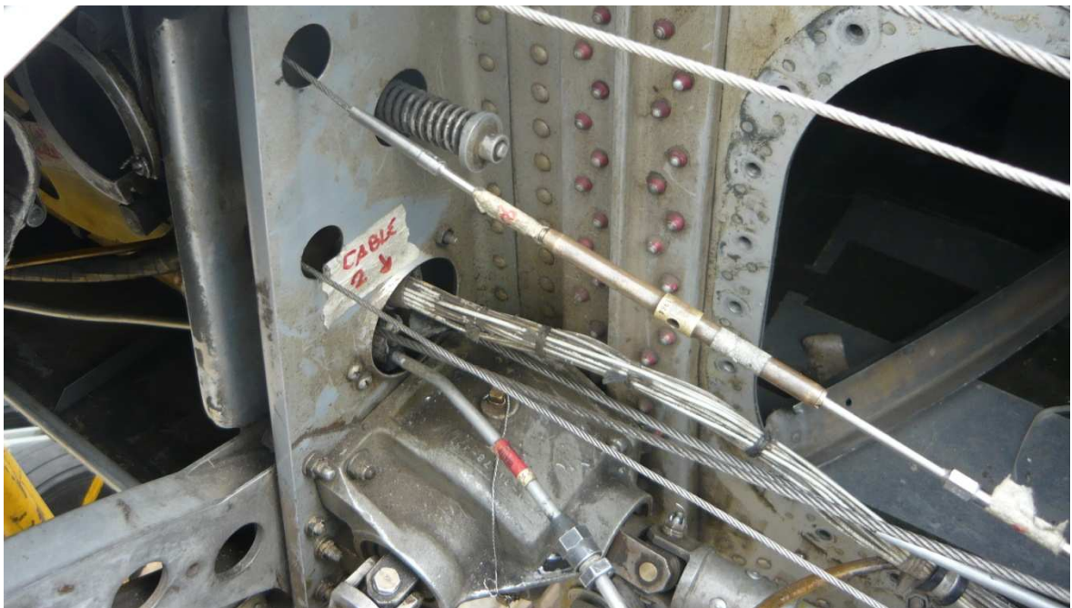
Figura 3.6: Turnbuckles de cable de control ubicado en la parte posterior del ala central
