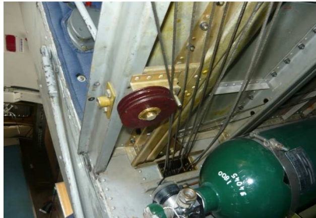
Figura 3.7: Cables de control en el compartimiento neumático
