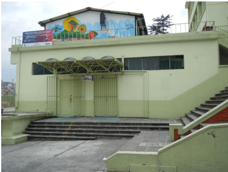
Figura 7.9 Vista de la estructura sobre el auditorio
