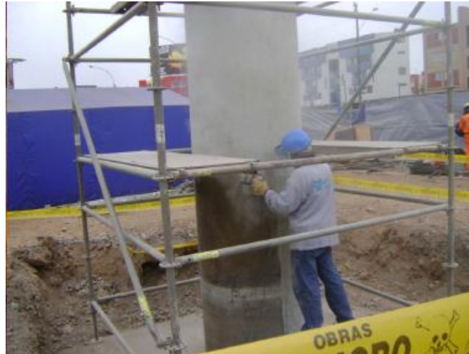
Figura 2.11 Trabajos de preparación de la superficie
