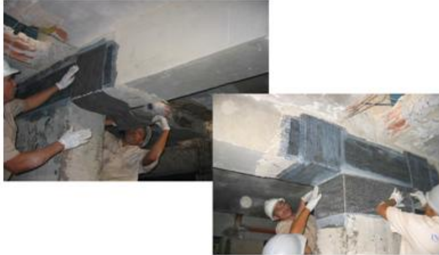
Figura 2.16 Colocación del refuerzo
