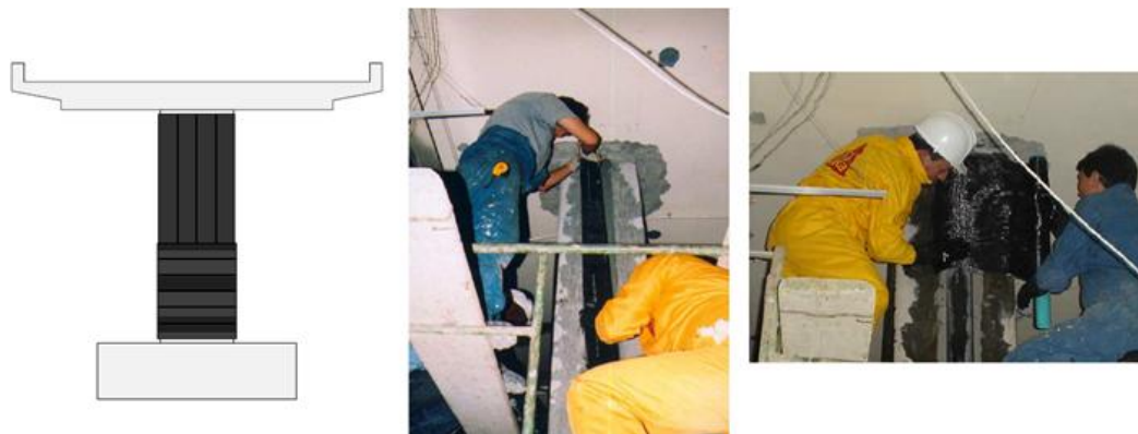
Figura 6.3 Esquema de reforzamiento a flexo-compresión
