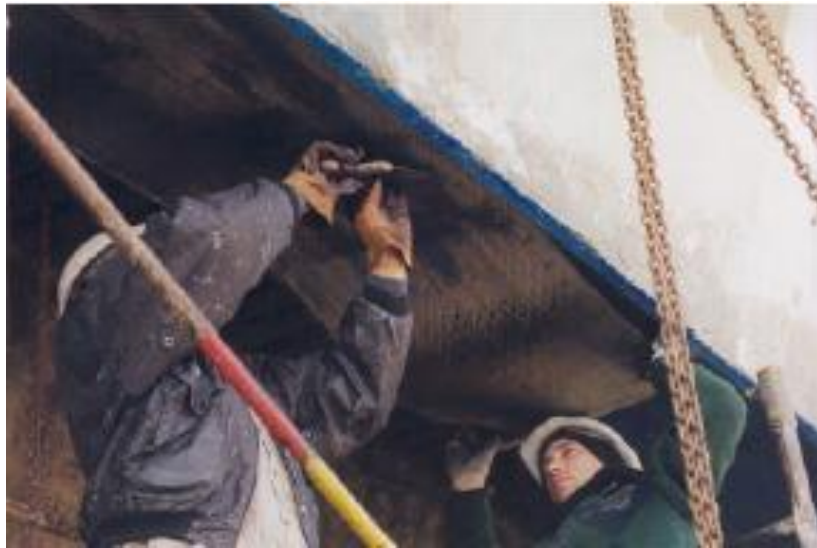
Figura 2.19 Colocación del FRP
