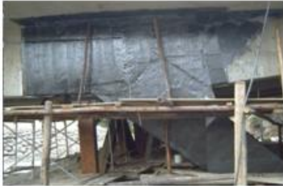
Figura 2.31 Reforzamiento de vigas y columnas del puente
