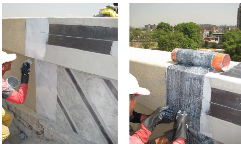
Figura 2.23 Reforzamiento con tejido SikaWrap 300C
