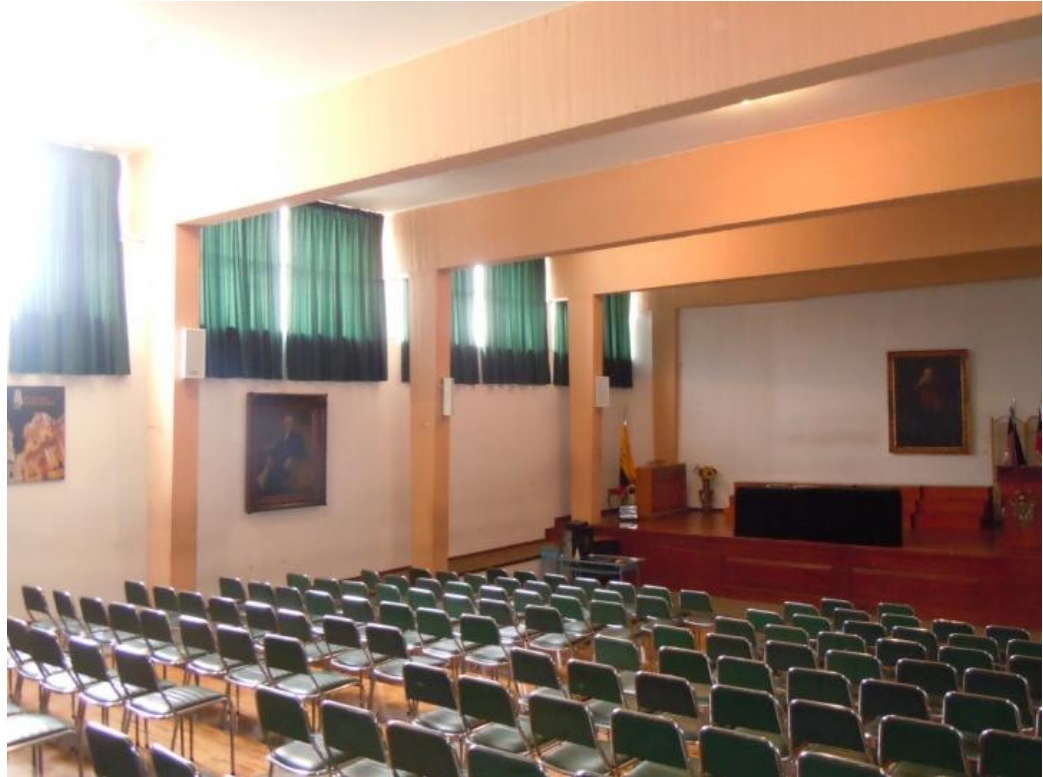
Figura 7.8 Vigas y columnas del auditorio
