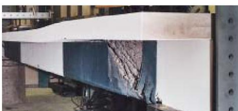
Después del ensayo a la falla
