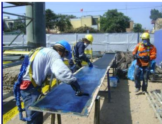
Figura 2.12 Preimpregnación de las fibras
