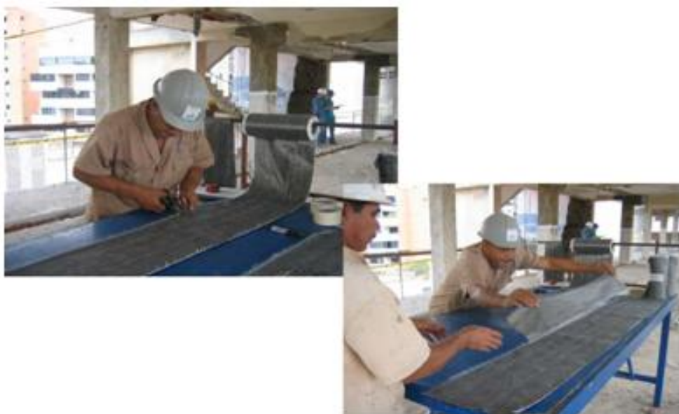
Figura 2.15 Corte del tejido SikaWrap 300C
