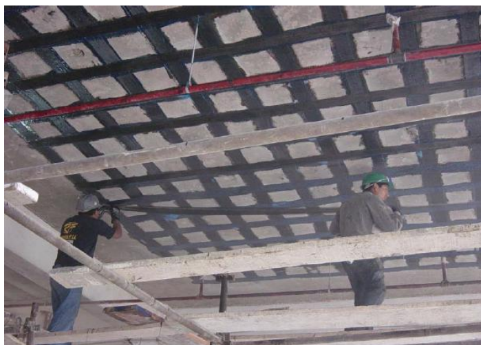
Figura 3.17 Colocación de refuerzo FRP en losa
