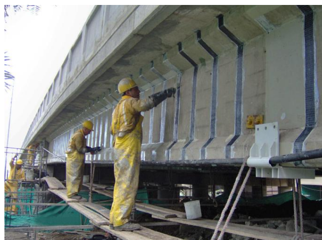
Figura 2.25 Colocación del refuerzo a cortante
