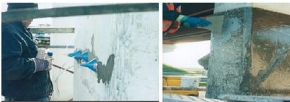
Figura 2.18 Inyección de fisuras y colocación del refuerzo
