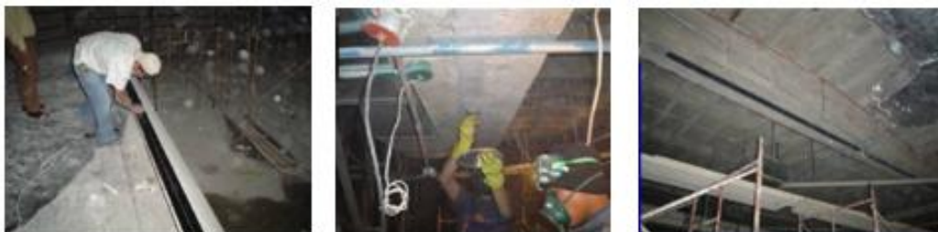
Figura 2.27 Instalación de las platinas de FRP
