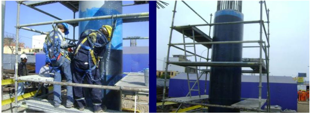
Figura 2.13 Colocación del refuerzo
