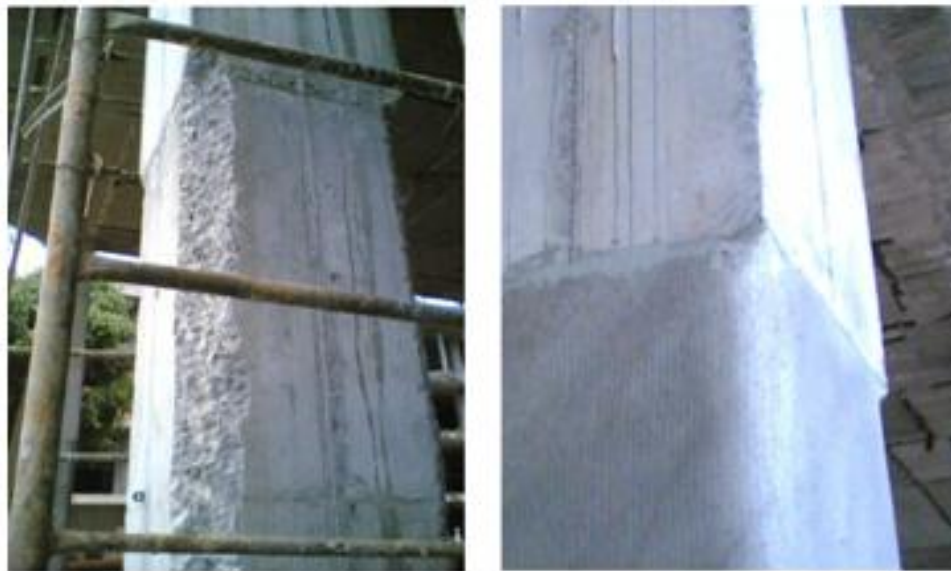
Figura 5.12 Redondeado de los bordes de las columnas
