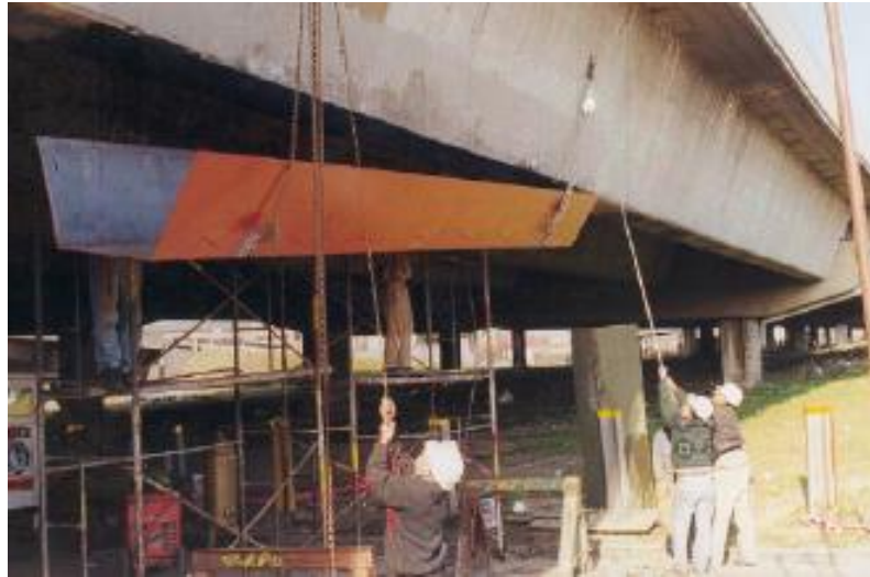
Figura 2.20 Instalación de refuerzo tipo cajón
