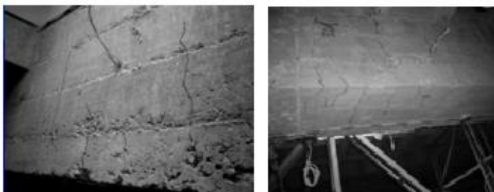
Figura 2.26 Fisuras existentes
