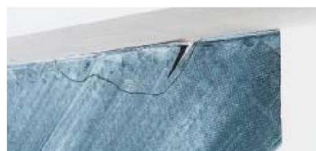
Después del ensayo a la falla
