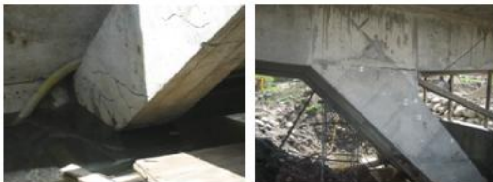
Figura 2.29 Fisuras detectadas
