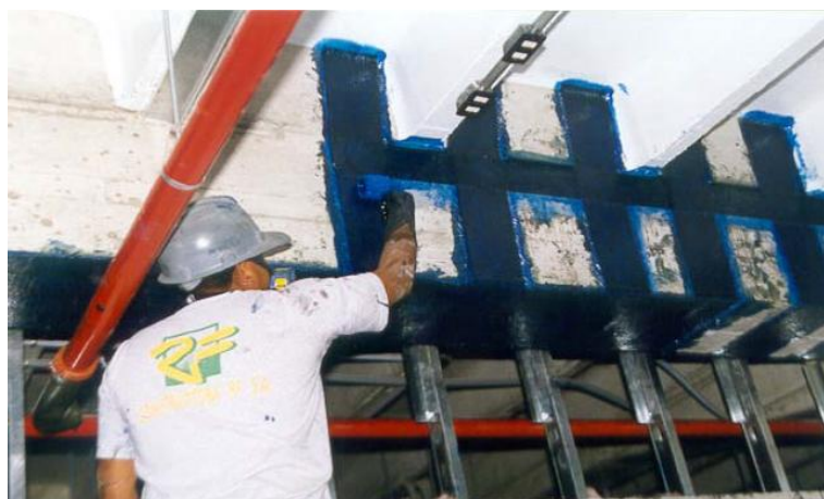
Figura 2.8 Refuerzo de vigas a cortante con FRP
