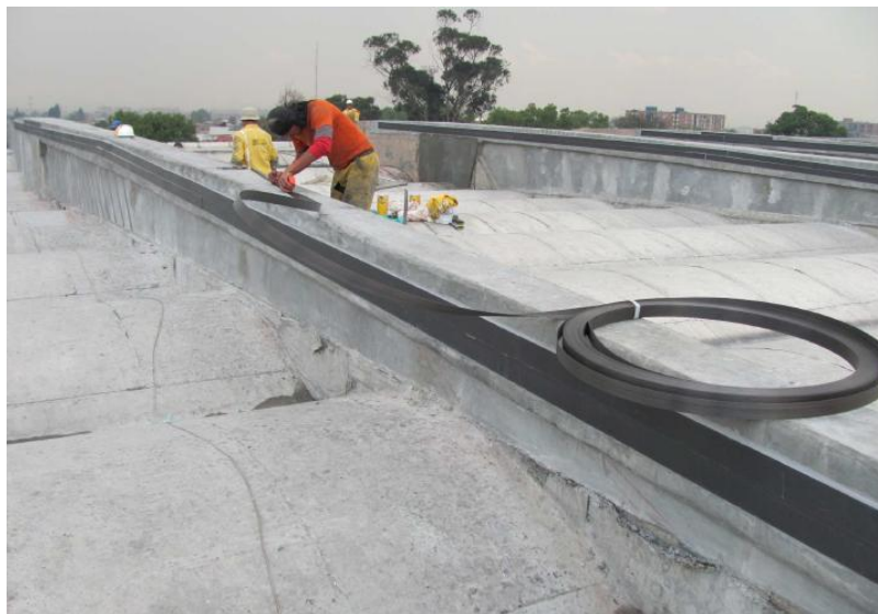
Figura 2.22 Reforzamiento con platinas Sika CarboDur
