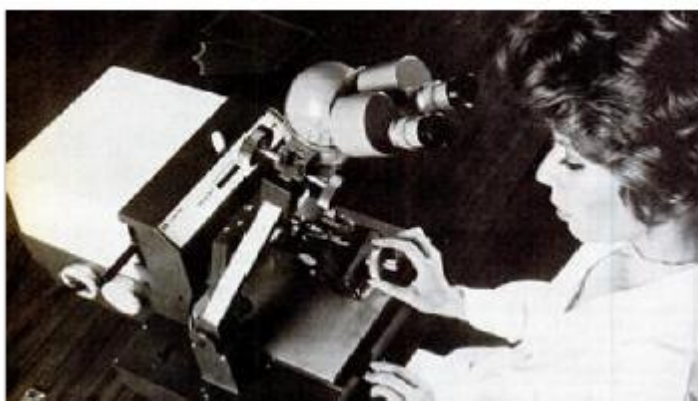
Figura 1.23: Ultramicrotomo Cambridge Huxley Mark 2 (LXB Huxley). Incorpora un motor bajo el dispositivo y el microscopio descansa sobre la mesa con opción de movimiento hacia adelante y atrás.
