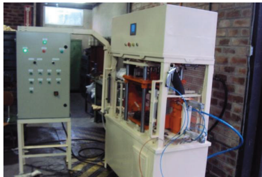
Figura 4-48 Instalaciones eléctricas y electrónicas de la máquina
