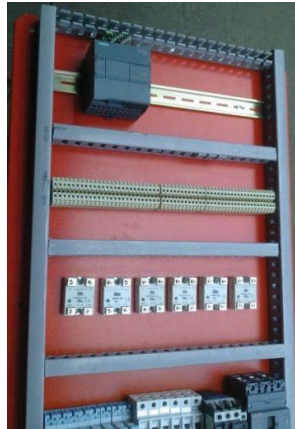
Figura 4-51 Rieles DIN, montaje de elementos
