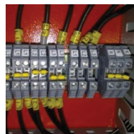
Figura 4-55 Energizado al tablero de control de la máquina
