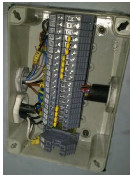
Figura 4-63 Montaje cajas de paso
