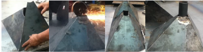
Figura 4-2 Montaje tolva de almacenamiento
