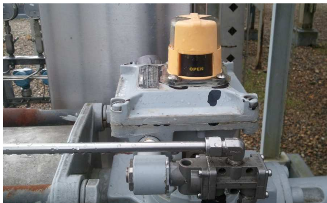
Figura 17. Válvula de Succión (SDV-2026) 41
