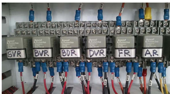
Figura 15. Relés Salidas Digitales 38
