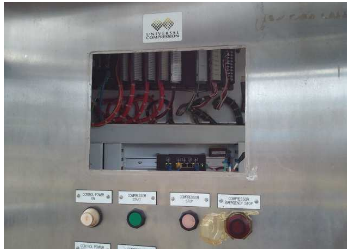
Figura 110. Vista Frontal del Panel Local sin el Terminal de Operador
