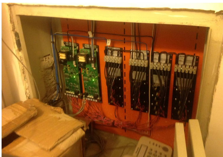
Figura 108: Foto de los Módulos de relés armados
