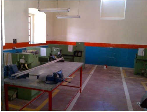
Fig 2. Acabado de las paredes en el Laboratorio de Mecánica Industrial.
