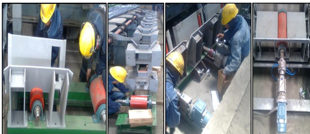
Gráfico N° 4.7: Montaje caminos de rodillos
