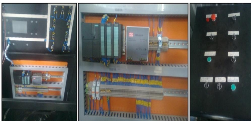
Gráfico N° 4.27: Distribución tablero de control
