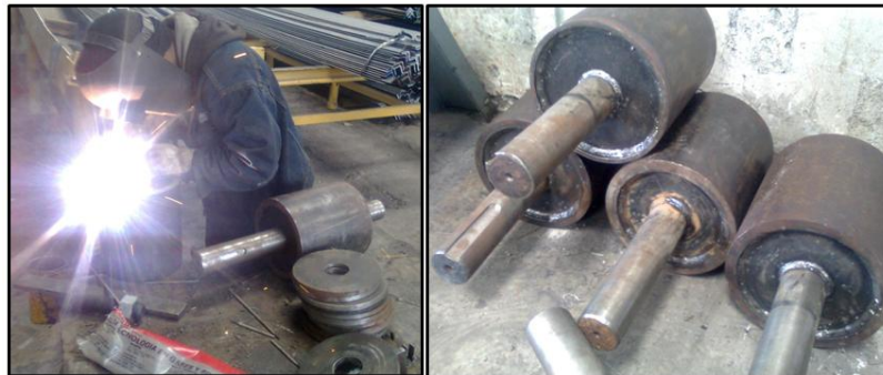
Gráfico N° 4.2: Construcción de rodillos
