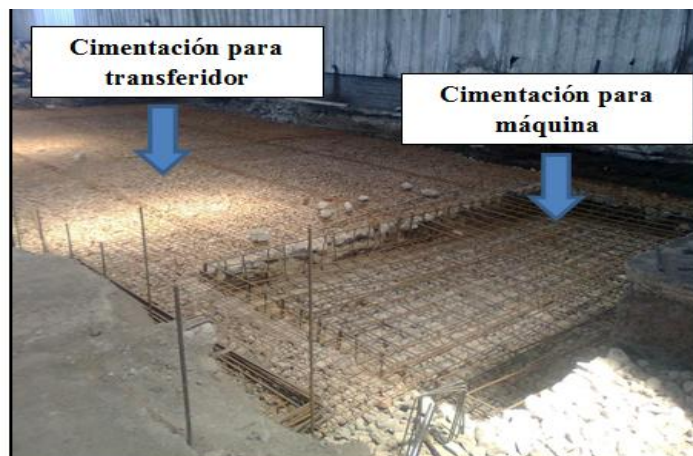
Gráfico N° 4.10: Preparación de terreno para cimentación del proyecto
