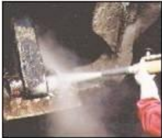
Figura 1 - Aplicación de sandblasting
