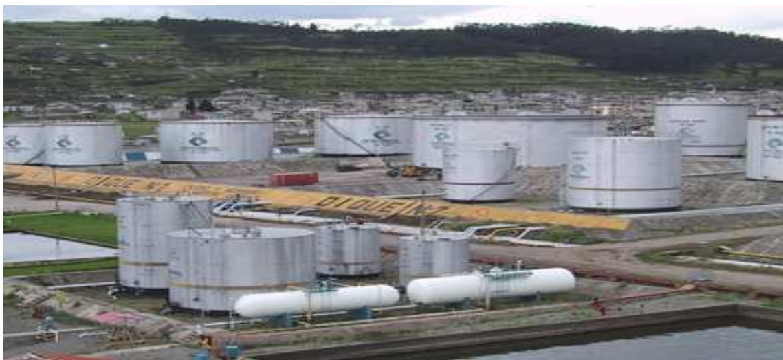
FOTOGRAFÍA 2. Tanques de almacenamiento Estación “El Beaterio”
