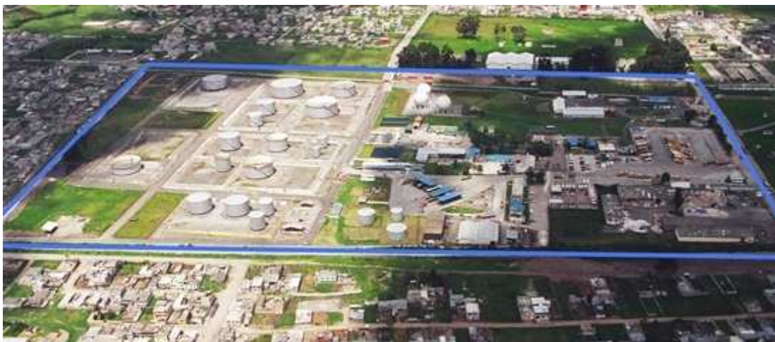
FOTOGRAFÍA 1. Estación de transferencia de combustibles “El Beaterio”
