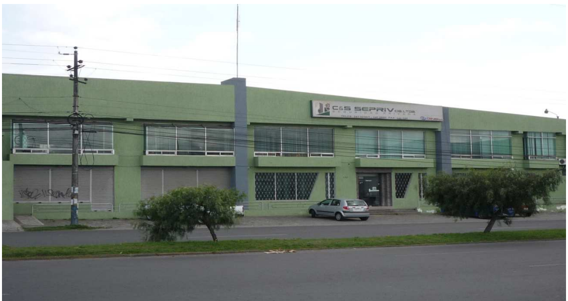
Fotografía 4: Edificio administrativo Sepriv-Quito
