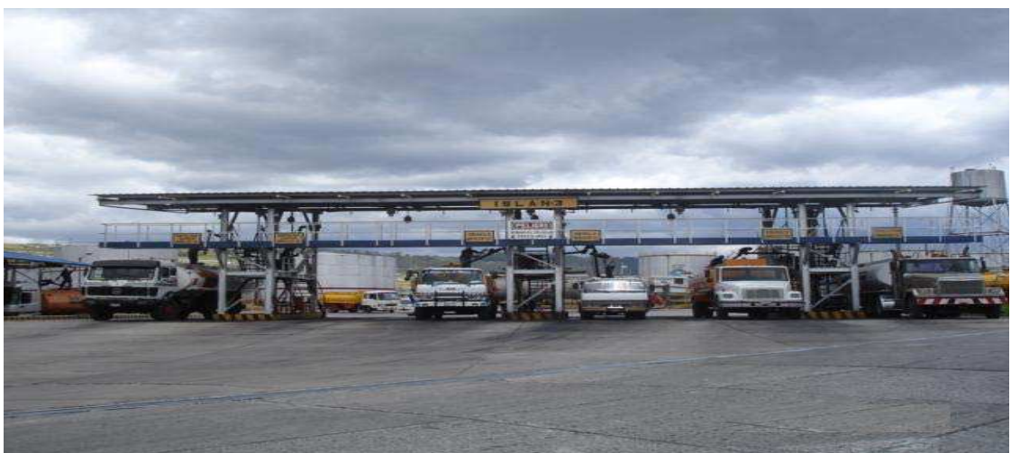
FOTOGRAFÍA 3. Isla de carga y distribución de Estación “El Beaterio”
