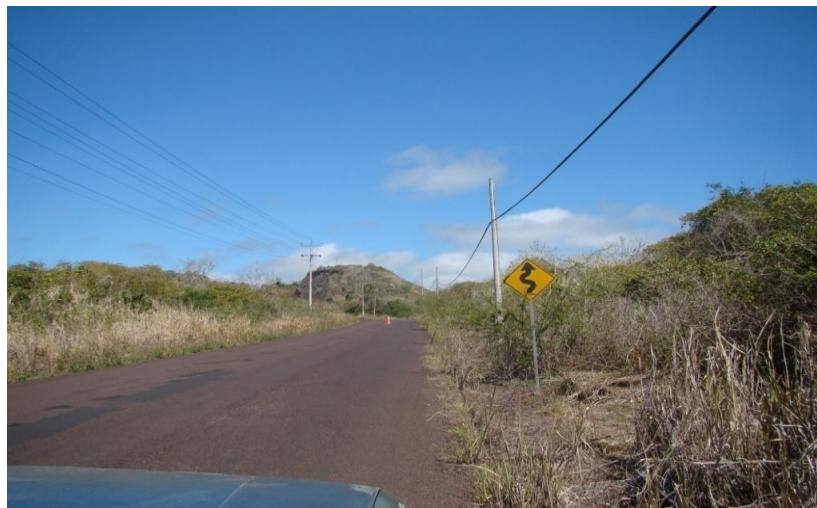
Imagen 4.18: Carretera vía a El Progreso
