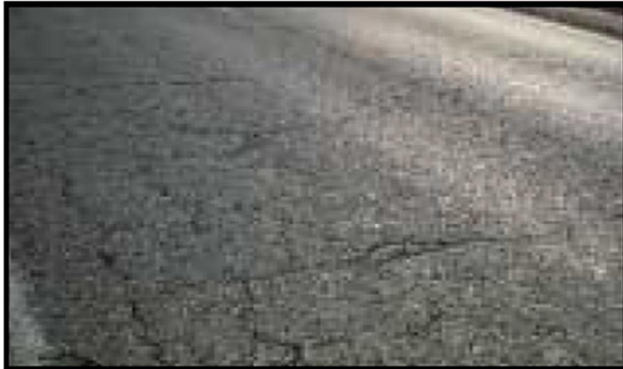
Foto 8: Falla de bloque de alta gravedad, ACP 2A.
