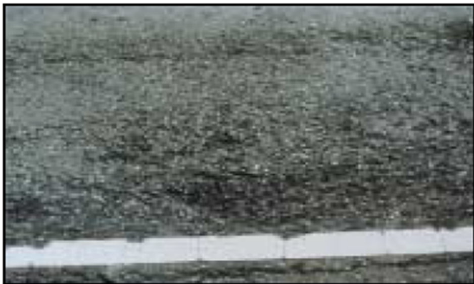
Foto 22: Perda de agregado fino y algún grueso, ACP 13.
