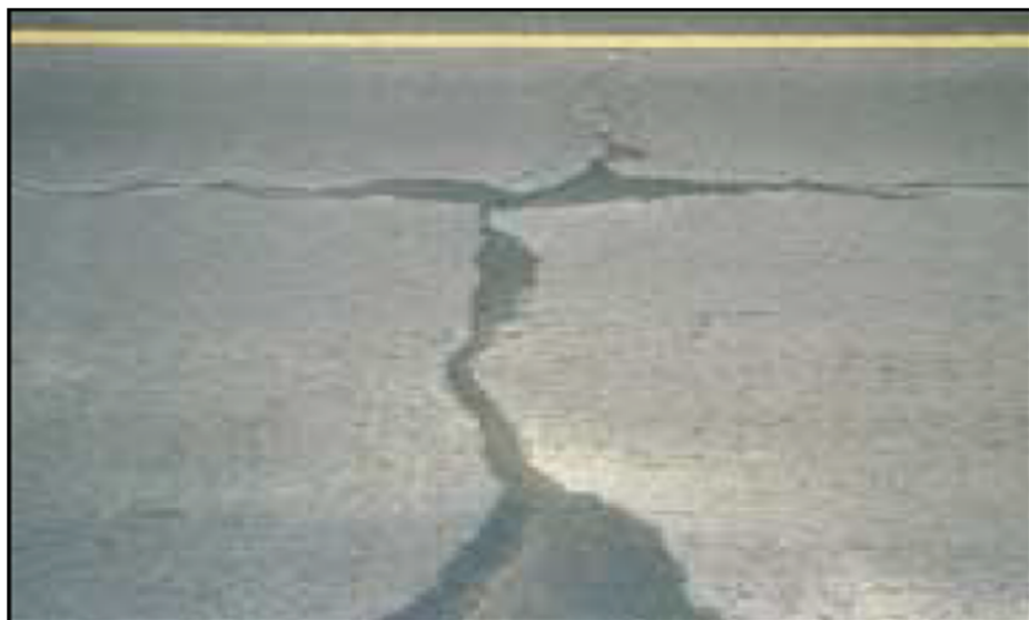
Foto 24: Agua sangrado y bombeo, ACP 15.
