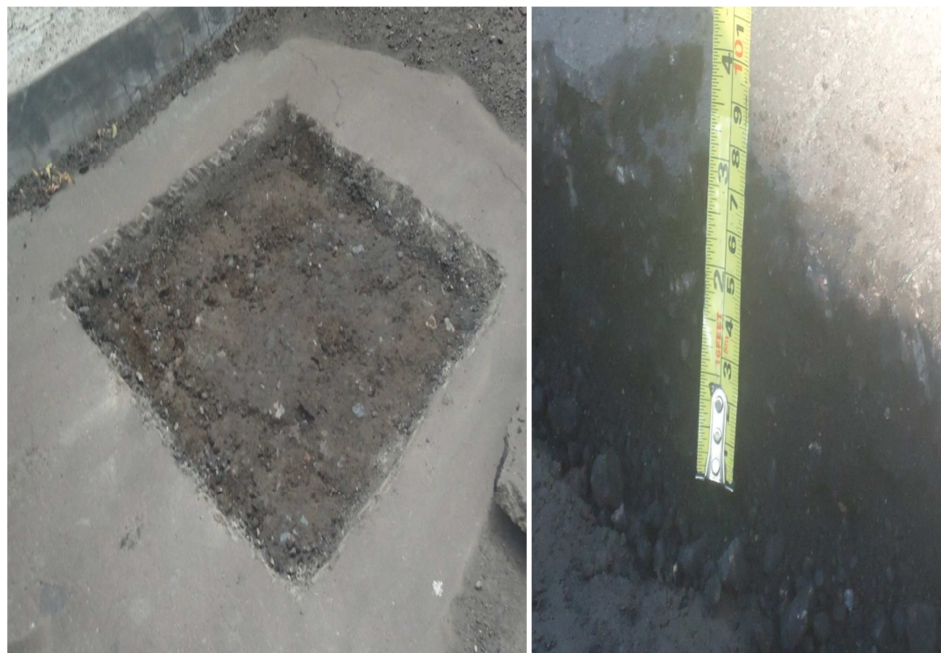
Foto 27: Espesor de la carpeta asfáltica.
