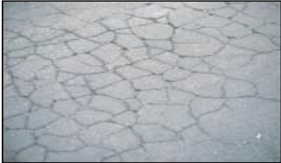
Foto 3: Patrón típico de Falla por fatiga, ACP1
