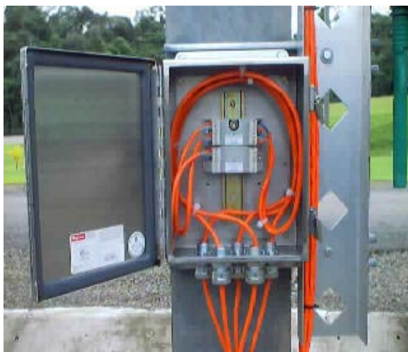
IMPLEMENTACION Y MONTAJE DE LA RED FIELDBUS EN CAMPO
