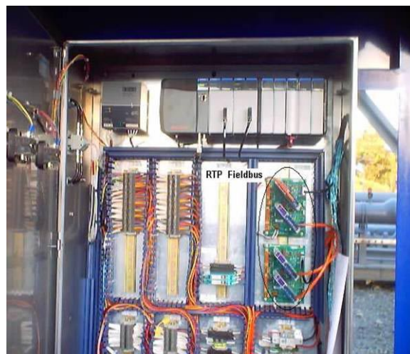
IMPLEMENTACION Y MONTAJE DE LA RED FIELDBUS EN CAMPO
