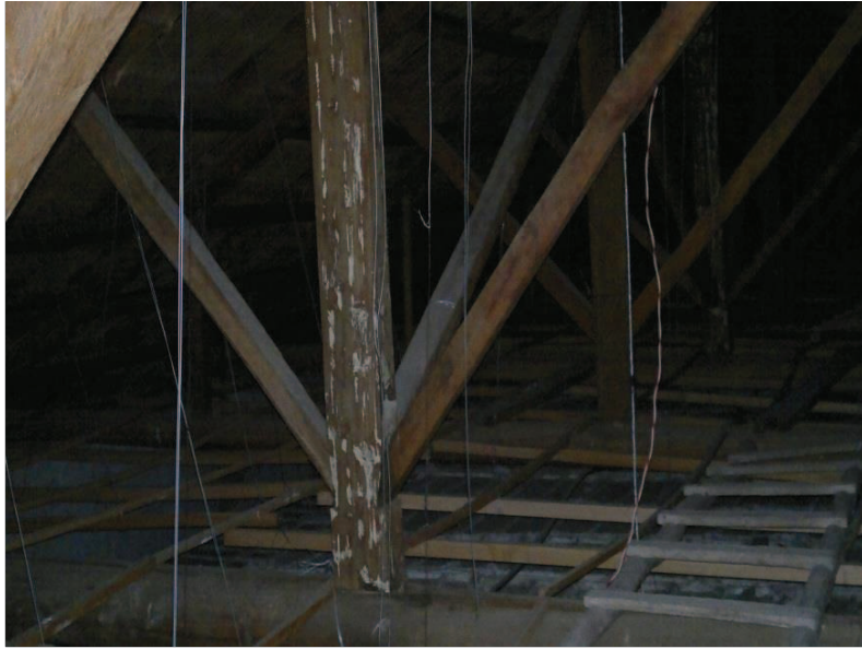
Figura 3.4 Fotografía al interior del tumbado / primera construcción
