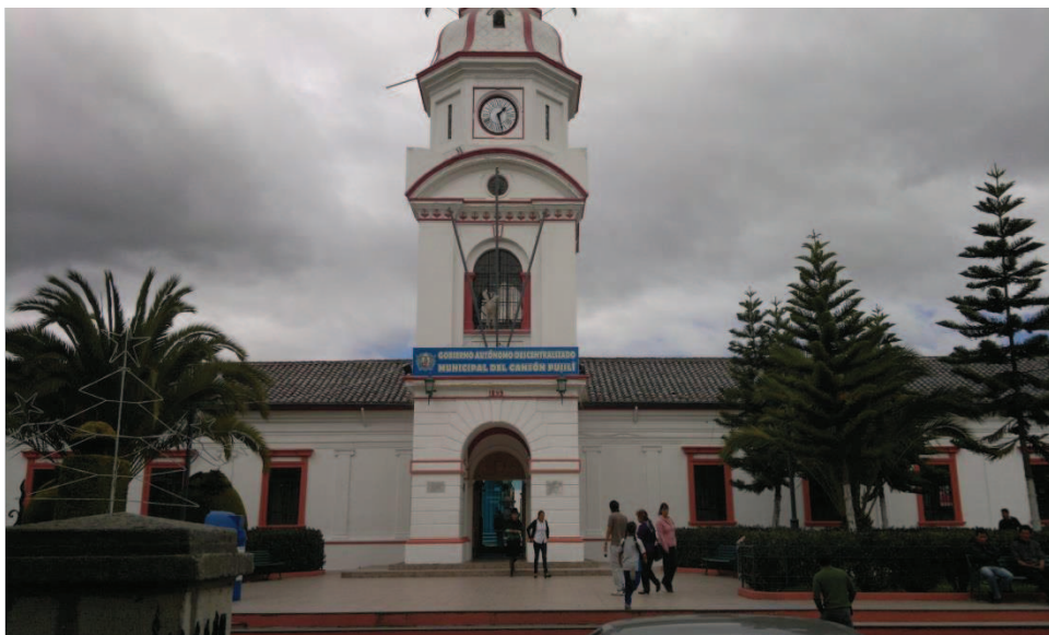
Figura 2.1 Vista al Palacio Municipal
