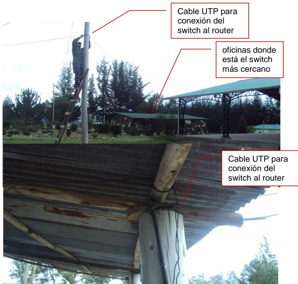
**Figura 3.6** Ubicación del cable UTP para conectar el router al switch más cercano
