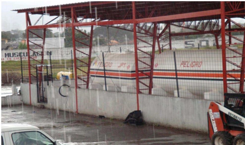
Figura 2 En esta figura podemos observar la cubierta del reservorio, la cual es muy pequeña para poder realizar el despacho del combustible aéreo.
