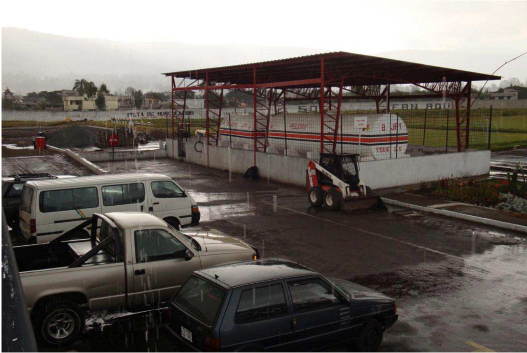
Figura 5 En esta figura podemos observar varios vehículos estacionados en el área de almacenaje del combustible lo que estaría atentando contra la seguridad.
