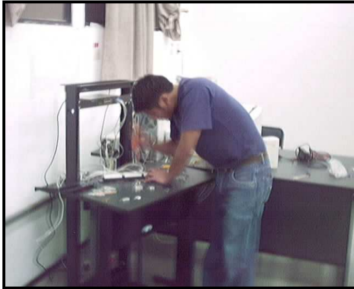
Figura A.10. Cripeado del cable UTP en un patch panel de 24 puertos
