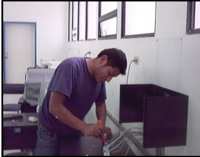
Figura A.4. Cripeado del cable UTP en el patch panel de 24 puertos
