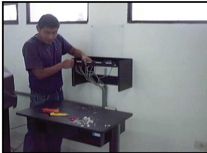
Figura A.5. Instalación del patch panel de 24 puertos en el rack de pared
