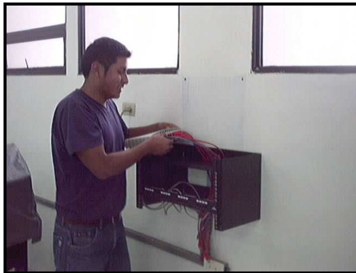
Figura A.7. Instalación de la hub y bandeja metálica en el rack de pared
