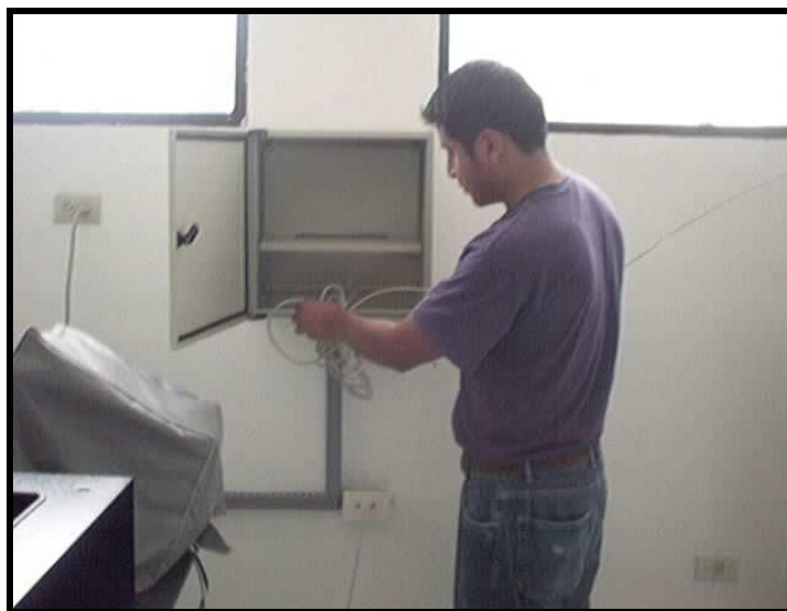
Figura A.1.Desmontaje del soporte de metálico en el laboratorio de redes
