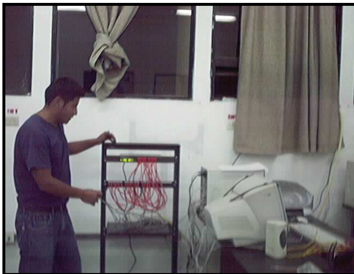
Figura A.11. Instalación de un switch D-link de 16 puertos ,un patch panel y patch cord en el rack de piso
