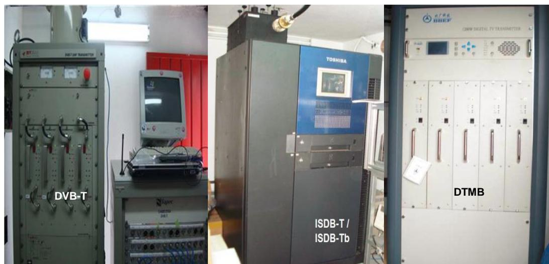
Figura 38. Transmisores utilizados en las pruebas TDT y que fueron instalados en el Cerro Pichincha
