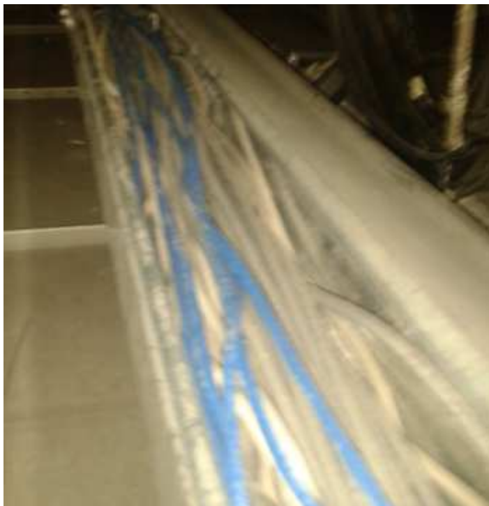
Figura 3.5 Tendido de cables sobre la bandeja
